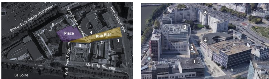
Figure 2. Zone d'étude (sources Google Earth et Google Maps ). À l'intérieur de l'îlot quelques constructions récentes (l'amphithéâtre Kerneis (1), un logement étudiant (2) et la BU (3)), coexistent avec des constructions plus anciennes et détériorées (un parking (4) et un logement collectif (5)).
