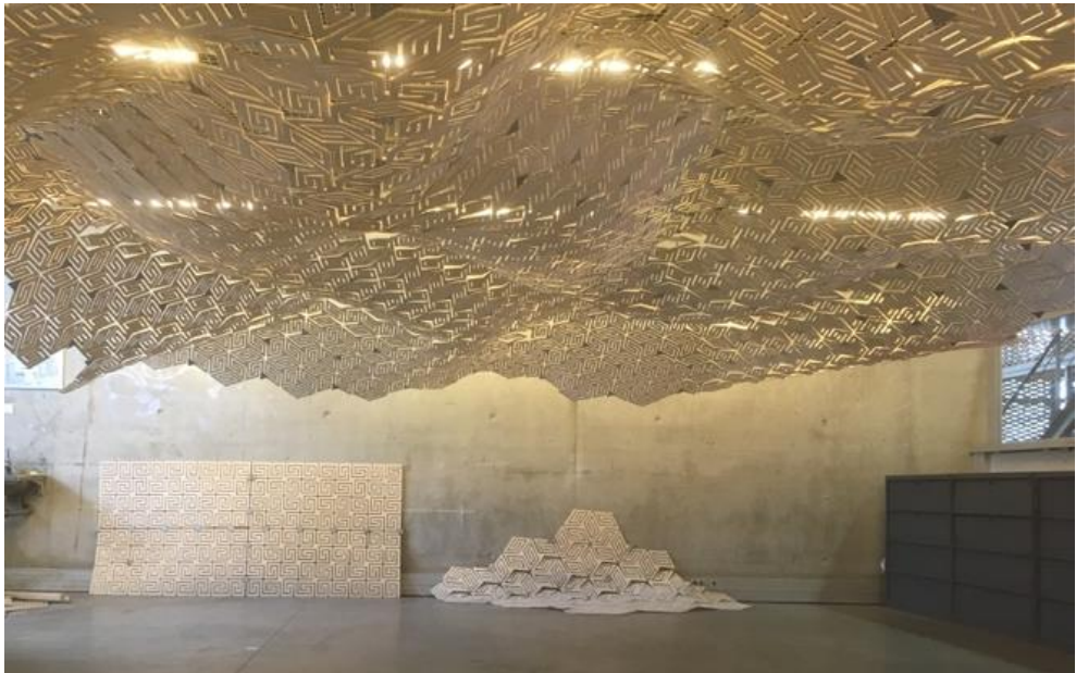
Figure 13. Pavillon à échelle 1, formé à partir de la nappe à motif hexagonal.
